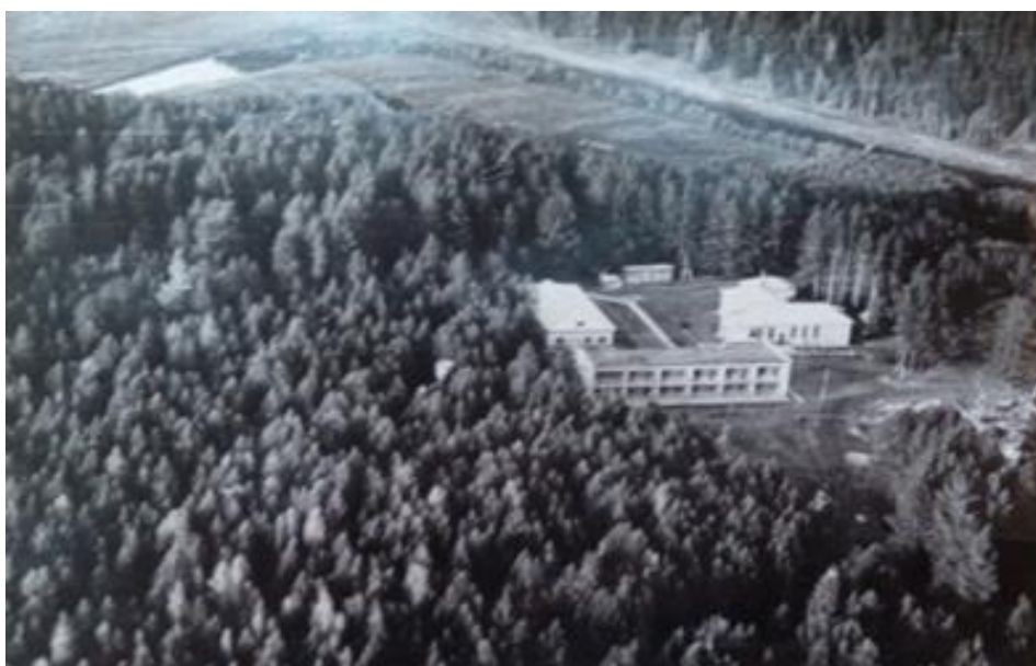
Рис.16. Начало строительства санатория «Карагай»
